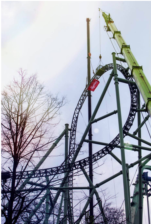
Bild 3: Montering av den sista delen av Top Hat (foto Liseberg) och ritningsdetalj för denna del av banan.
